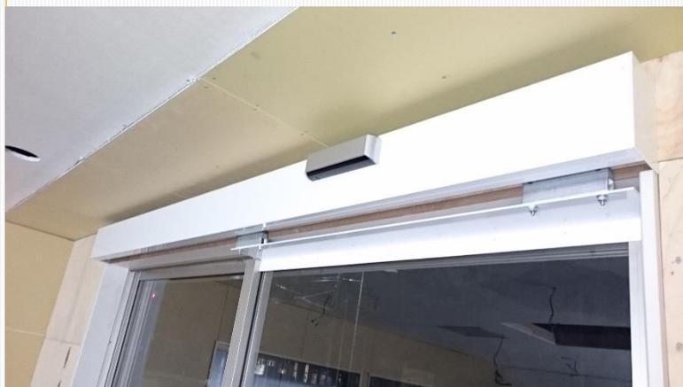
壁の中入っている自動ドアがそとに出ており、手動ドアと連結している、それがFAS07です。モーター、コントローラーなどは一般的な自動ドアと同じものを使用しています。各種センサーによる開閉など、普通の自動ドアができることはすべて可能であり、電源を落とせば手動ドアとして使用できます。
